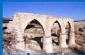
Acueducto de San Rafael, siglo XVI sobre el cauce del río Vinalopó en Petrer.
