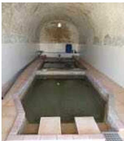
Figura 3: Partidor de aguas. Fuente: elaboración propia
