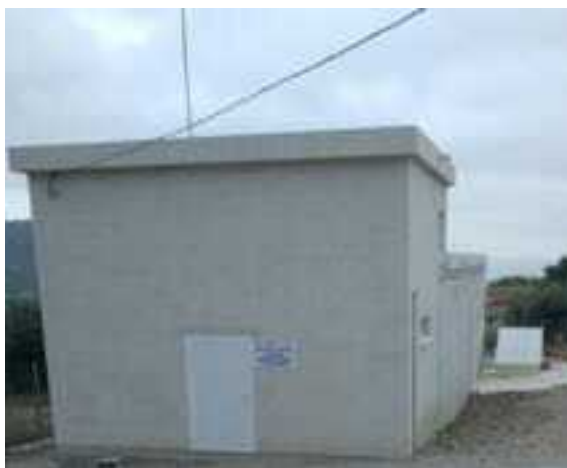
Figura 4: Depósito de agua. Fuente: elaboración propia
