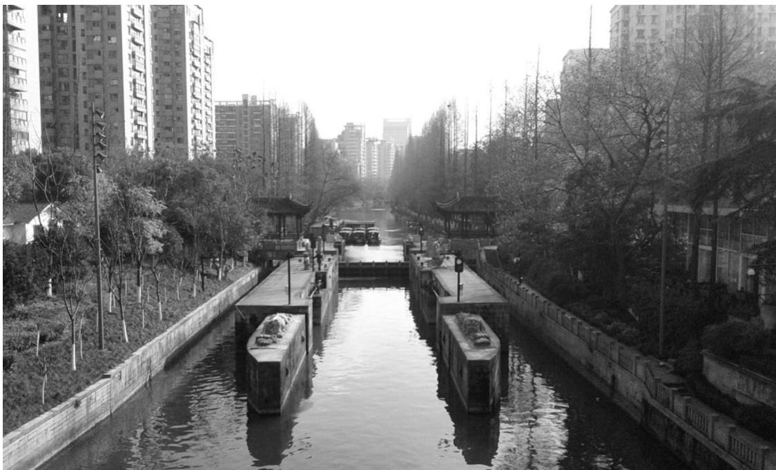
Figura 3. Esclusa de Bazi en el Canal del Este. Fuente: foto tomada por el autor.
