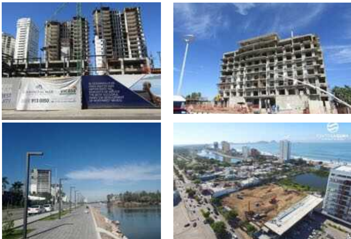
Figura 3. Desarrollos inmobiliarios verticales en construcción. Fuente: Diversas 3
