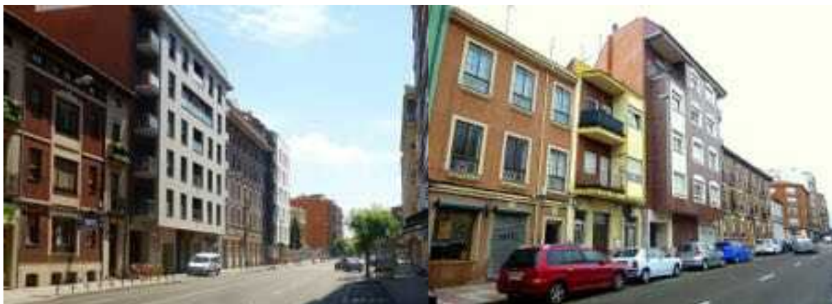
Fig. 4. Los derribos en Álvaro López Núñez (izda.) y La Corredera (dcha.) introducen nueva arquitectura con cuerpos excesivamente salientes. Fuente: elaboración propia.
